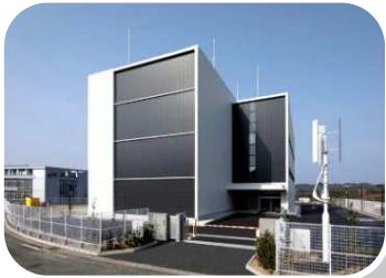
岡山データセンタ
