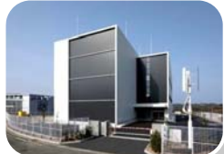
岡山データセンター
